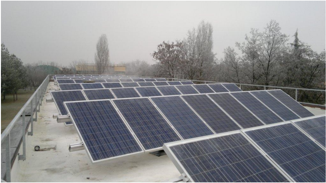
Figura 30 - Foto dell'impianto fotovoltaico della mensa comunale di Soragna
