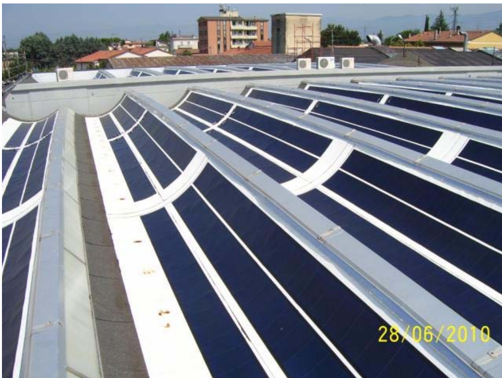
Figura 25 - Applicazione per incollaggio su superfici curve, di moduli in silicio amorfo
