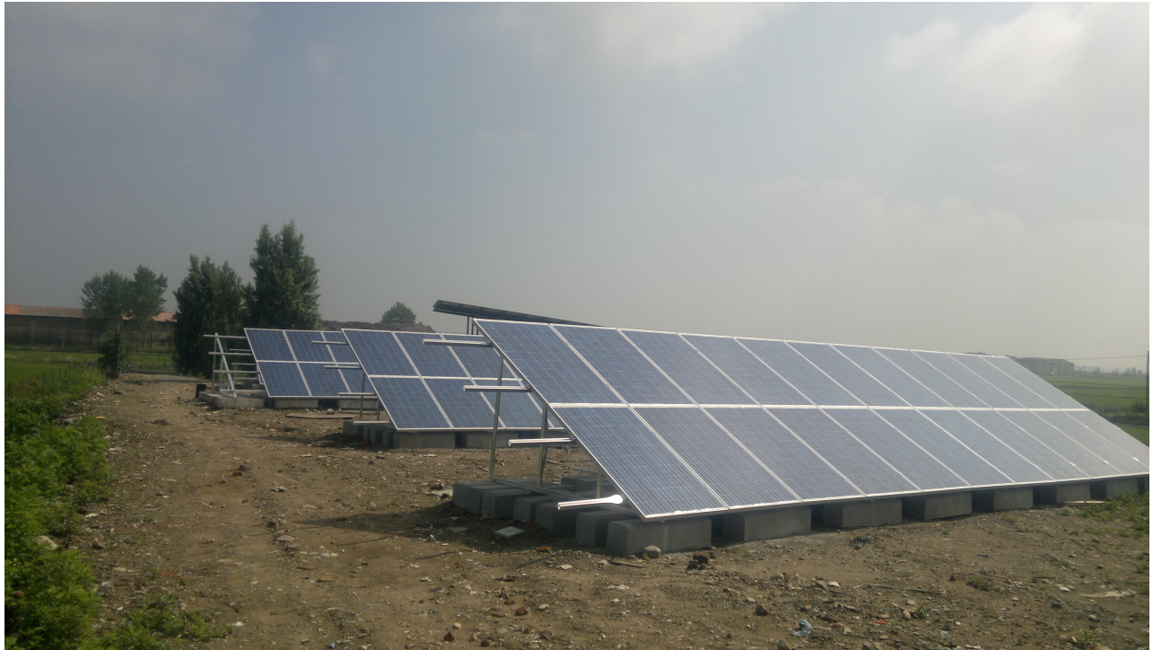
Figura 24 – Ancoraggio al suolo tramite zavorra dei supporti che sorreggono i pannelli
