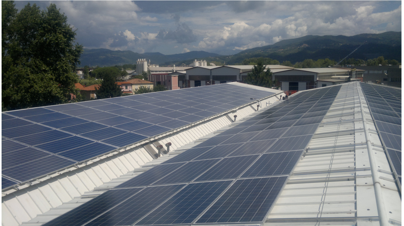
Figura 26 - Fissaggio dei pannelli tramite profili in alluminio
