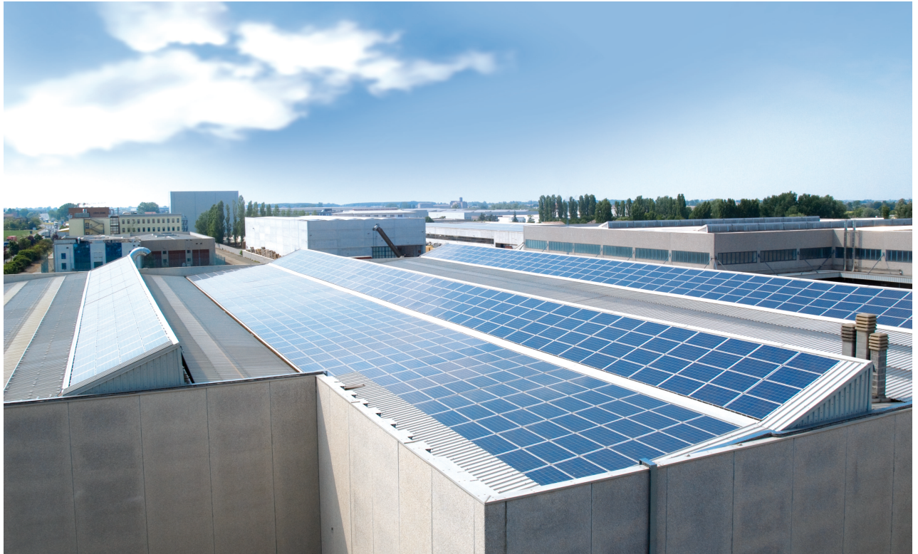
Figura 5 – Esempio di impianto fotovoltaico (Magazzino Bonatti, PR)
