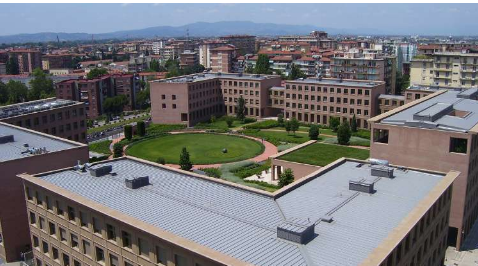
Cassa di Risparmio di Firenze - Firenze (FI): Copertura con lastre a giunti drenanti in alluminio
