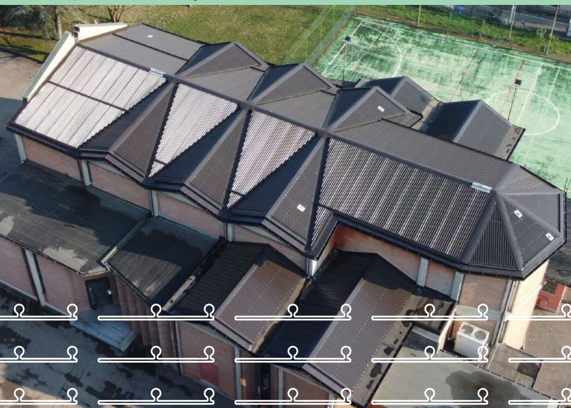
Parrocchia di San Lazzaro - Parma (PR): Copertura con lastre grecate in alluminio
