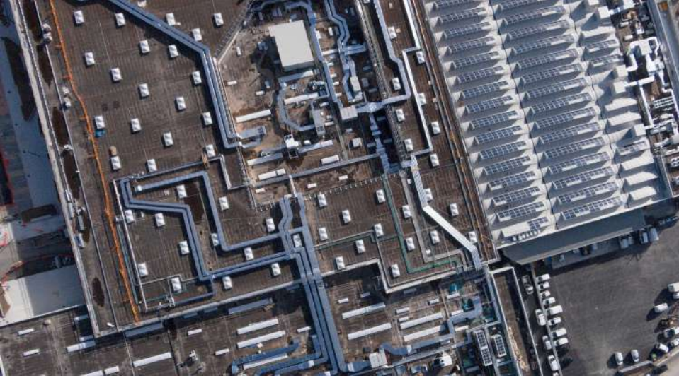
Centro commerciale Maremà - Grosseto (GR): Copertura in membrana bitume-polimero incollata a freddo
