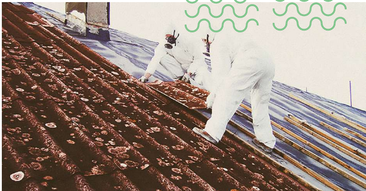
Copertura edificio civile - Parma (PR): Rimozione di lastre in amianto a matrice compatta
