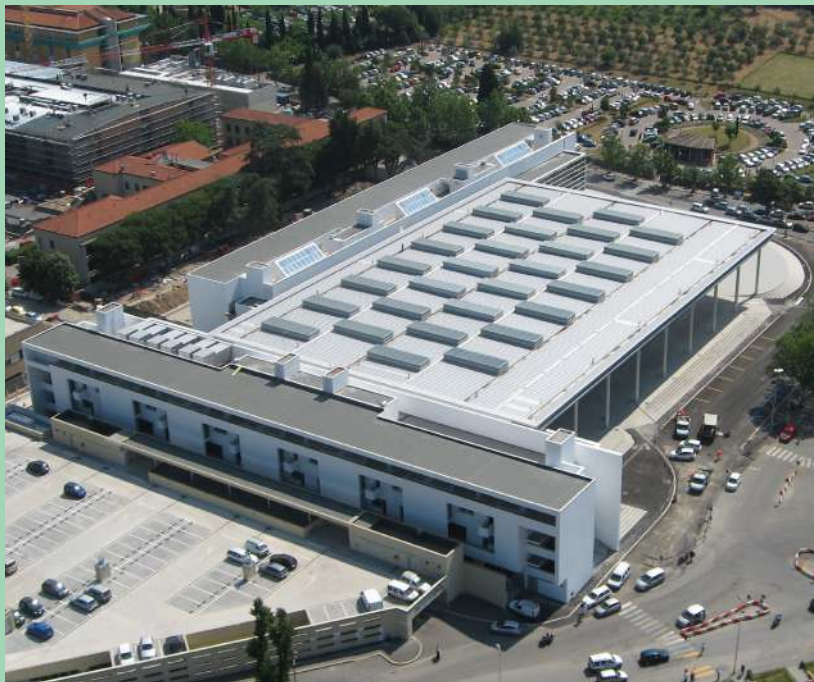
Ospedale di Careggi - Firenze (FI): Copertura con lastre a giunti drenanti in alluminio
