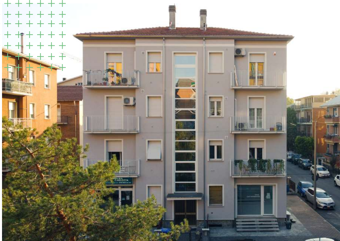
Condominio Donatello - Parma (PR): Riqualificazione energetica mediante cappotto termico, copertura coibentata, caldaie a condensazione e serramenti a taglio termico
