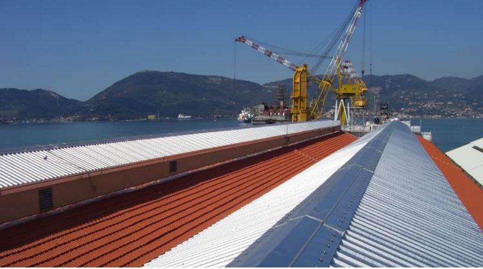
Stabilimento Fincantieri - Muggiano (SP): Copertura con lastre grecate multistrato e tegole in laterizio
