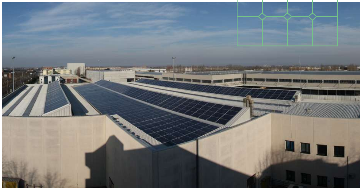
Stabilimento Bonatti - Parma (PR): Impianto fotovoltaico da 200 kWp in silicio policristallino
