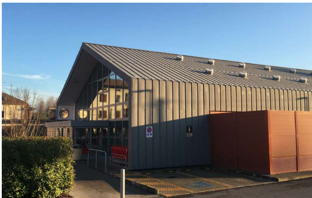
Centro Commerciale Coop - Rovereto sul Secchia (MO):
