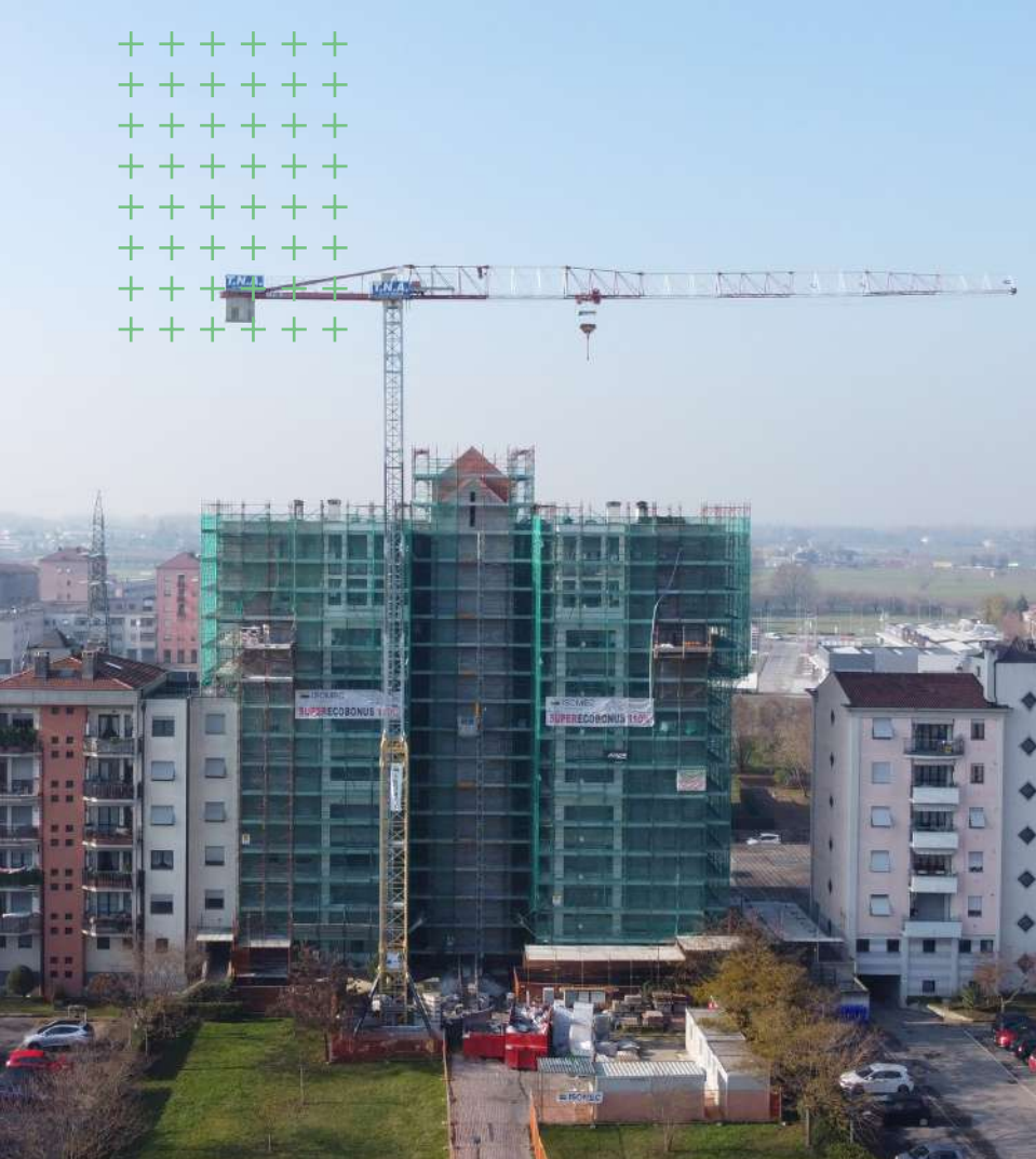
Condominio Giuditta - Parma (PR): Riqualificazione energetica mediante cappotto termico, copertura coibentata, nuove caldaie a condensazione e serramenti a taglio termico
