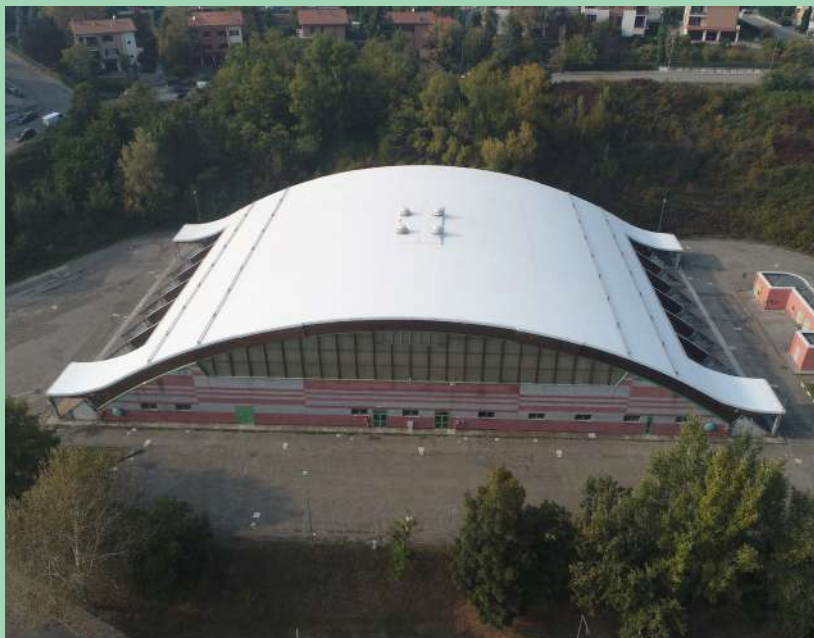
Palasport - Salsomaggiore Terme (PR): Copertura in membrana sintetica bianca termoriflettente (TPO)
