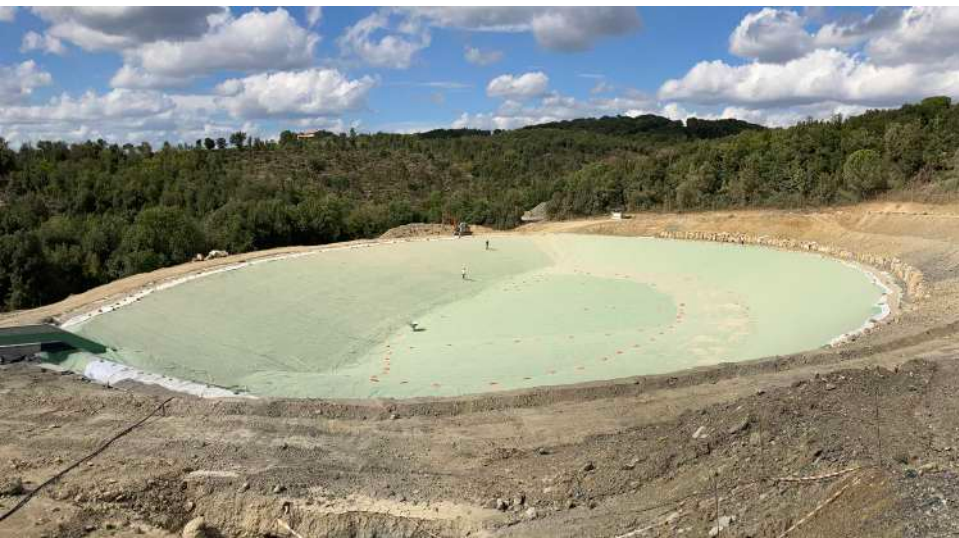
Podere Osteriaccia - Montalcino (SI): Impermeabilizzazione bacino in membrana sintetica (TPO)
