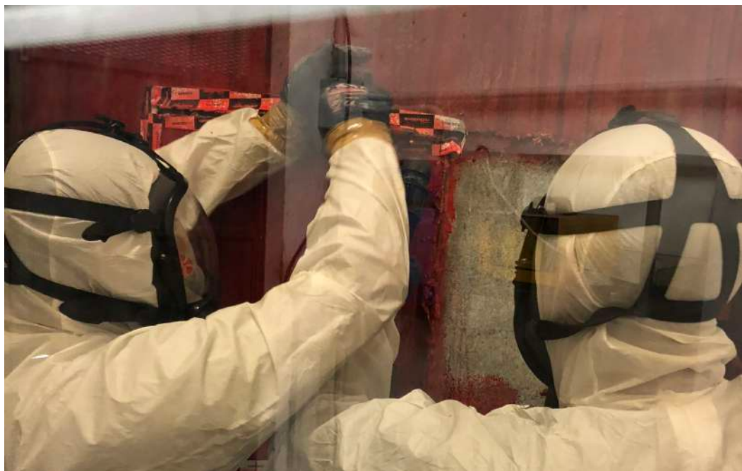
Stabilimento Bormioli - Castelguelfo (PR): Rimozione di rivestimento in amianto a matrice friabile
