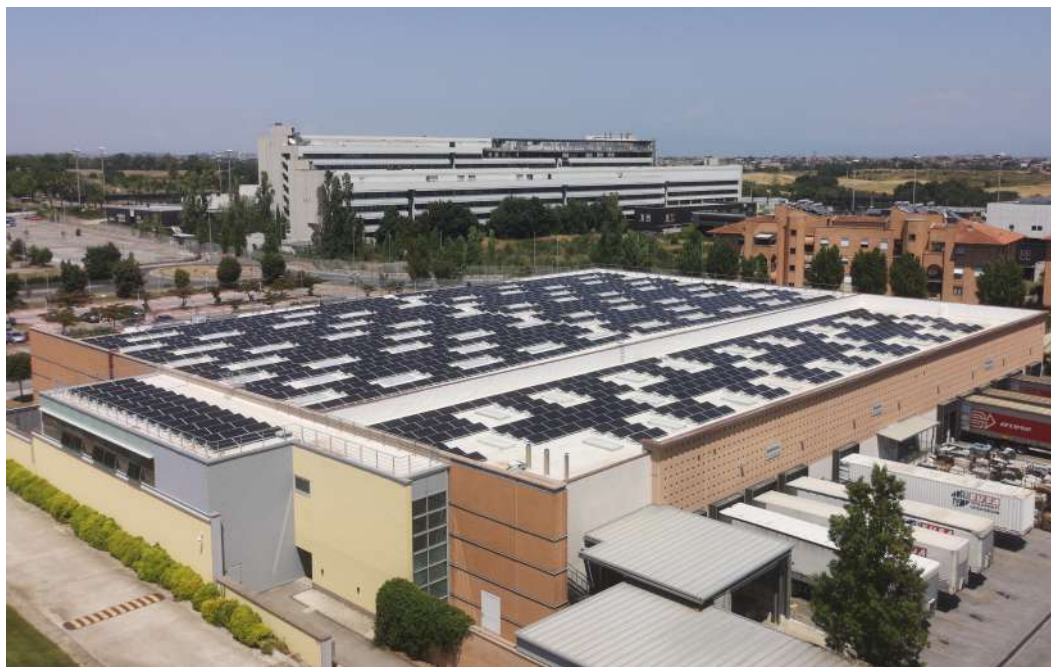
Stabilimento Toyota - Roma (RM): Copertura e impianto fotovoltaico da 500 kWp in silicio monocristallino
