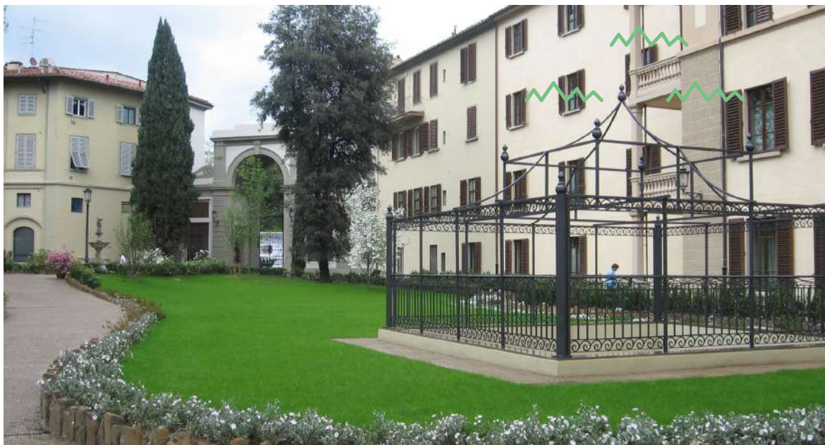
Hotel Four Season Palazzo Gherardesca - Firenze (FI): Impermeabilizzazione e giardino pensile intensivo
