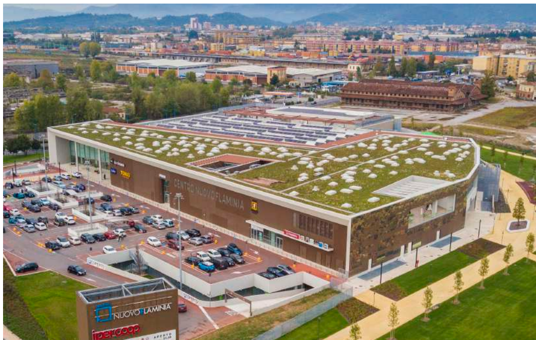
Centro Commerciale Nuovo Flaminia - Brescia (BR): Impermeabilizzazione e giardino pensile estensivo
